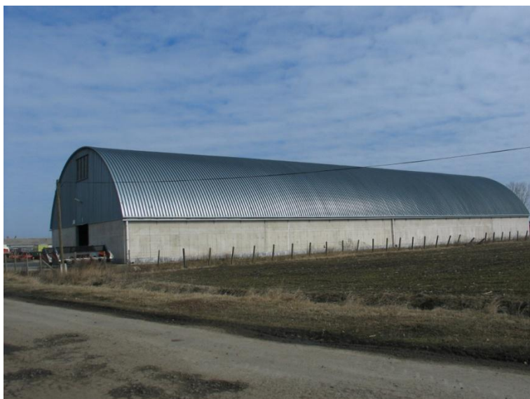
47. ábra Újépítésű síktároló (Tároló kapacitás 5000 t.).
