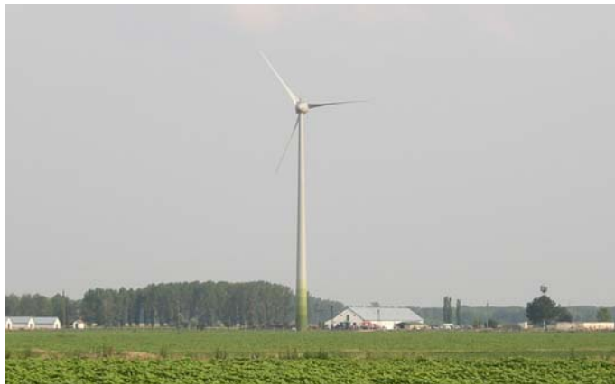
4.48. ábra Szélerőmű, Erk településen (Enercon E-48, 800 kW, 76 m) (forrás: saját felvétel)
