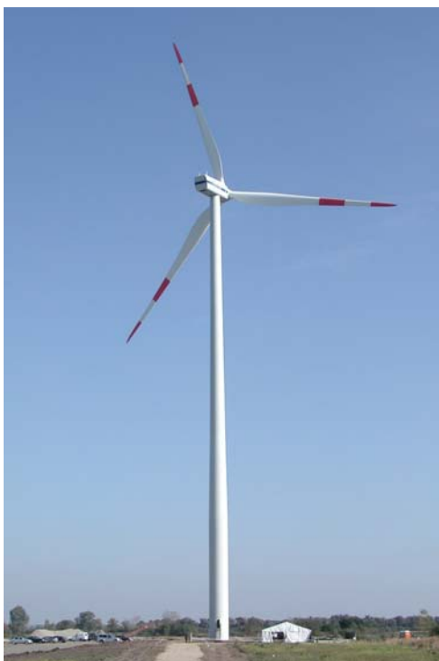
4.49. ábra Szélerőmű, Felsőzsolca településen (Vestas V-90 1,8MW, 105 m) (forrás: saját felvétel)
