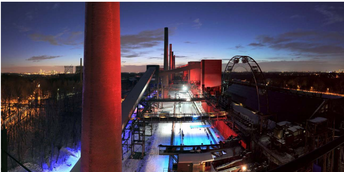
23. ábra: A Zollvereini esti megvilágításban
